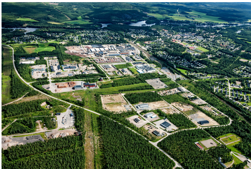
Nyfors datacentersite i förgrunden. Foto: Bergslagsbild AB.
